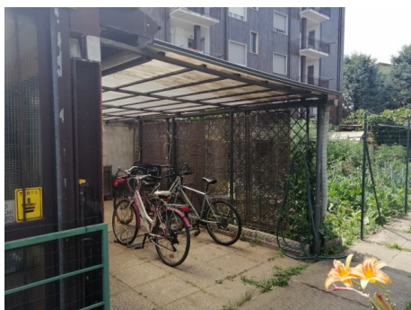
Corpo D tettoia
